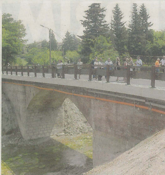
L'inaugurazione del ponte per l'accesso a frazione Crebini
